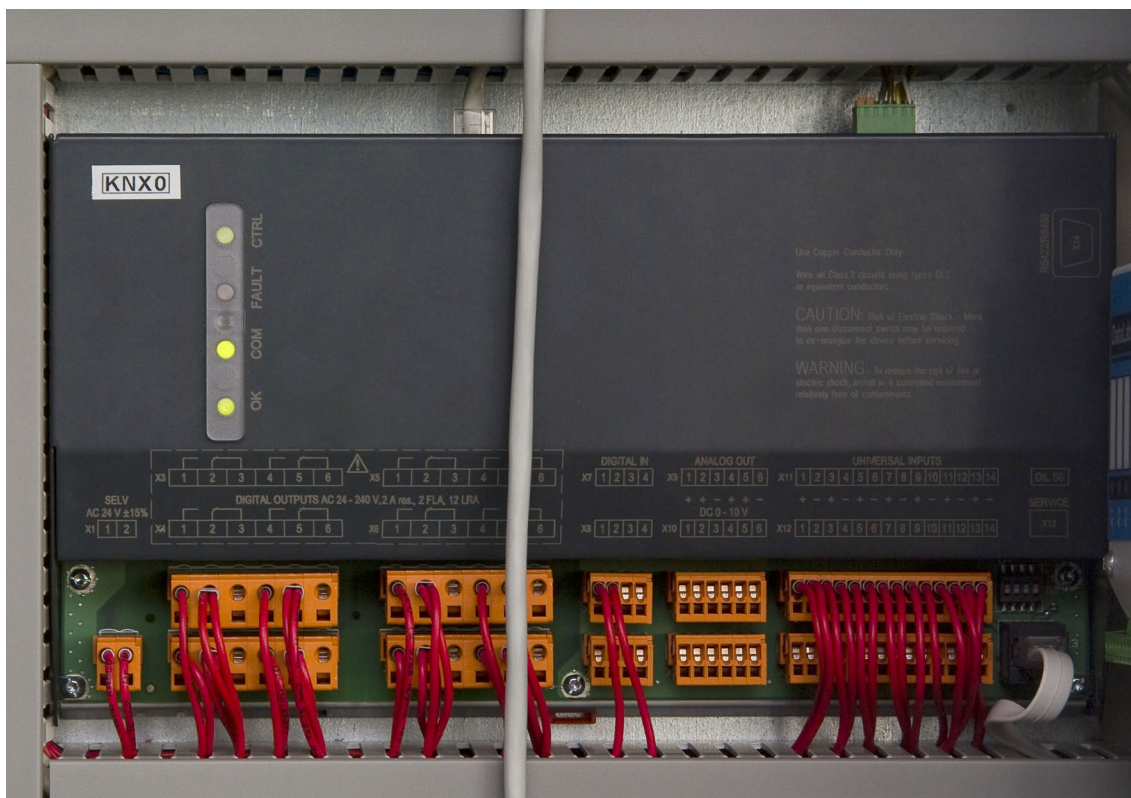
Obrázek 12 Centrální PLC Siemens Saphir ACX32
