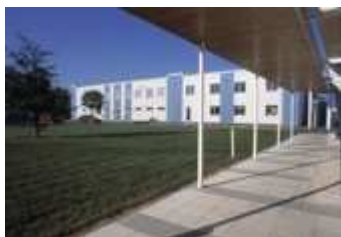
Obr. 11. Komplex firmy Arche
