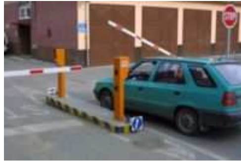
Obr. 5. Integrace systému pro rozpoznání SPZ se závorou
