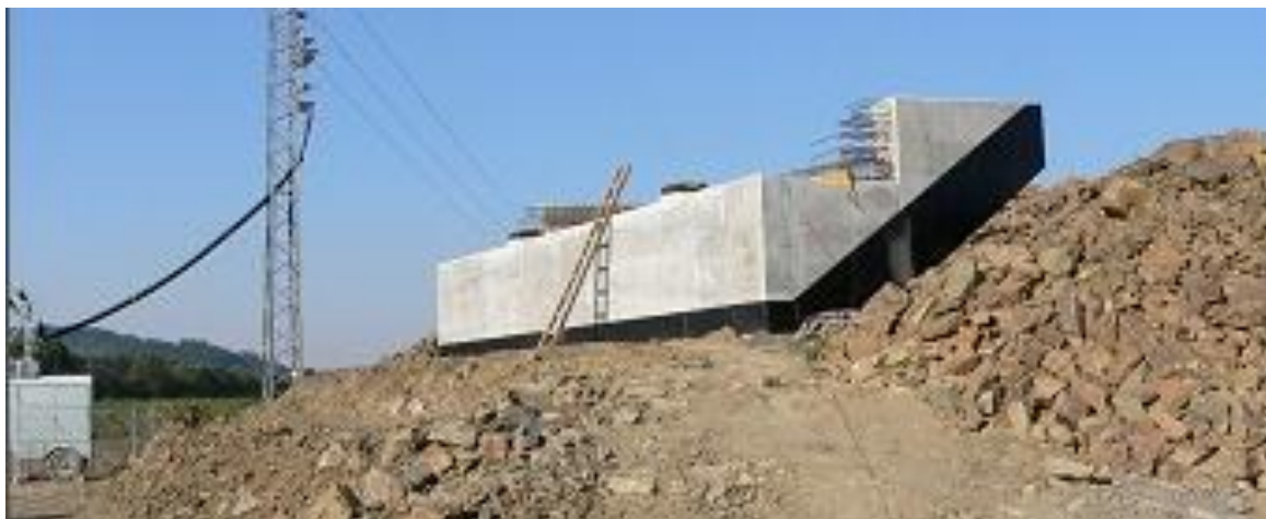
Obr. 6: Příprava nosných konstrukcí. MÚK – Ratiboř. [27]
