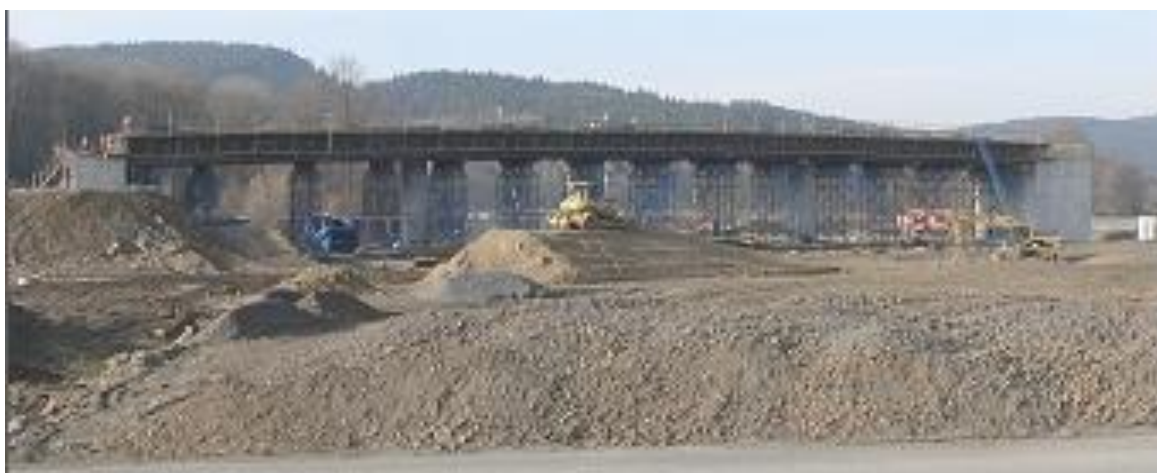
Obr. 7: Na tomto snímku je zachycena příprava mostního oblouhu MÚK – Semetín. Stavba takového rozsahu, byla na místní poměry, velkou a pro mnohé z nás velice zajímavou. [27]
