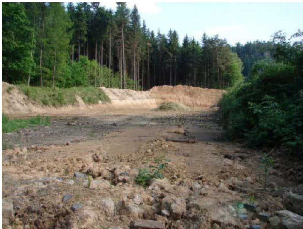
Obr. 44. Pohled na prvotní terénní úpravy
