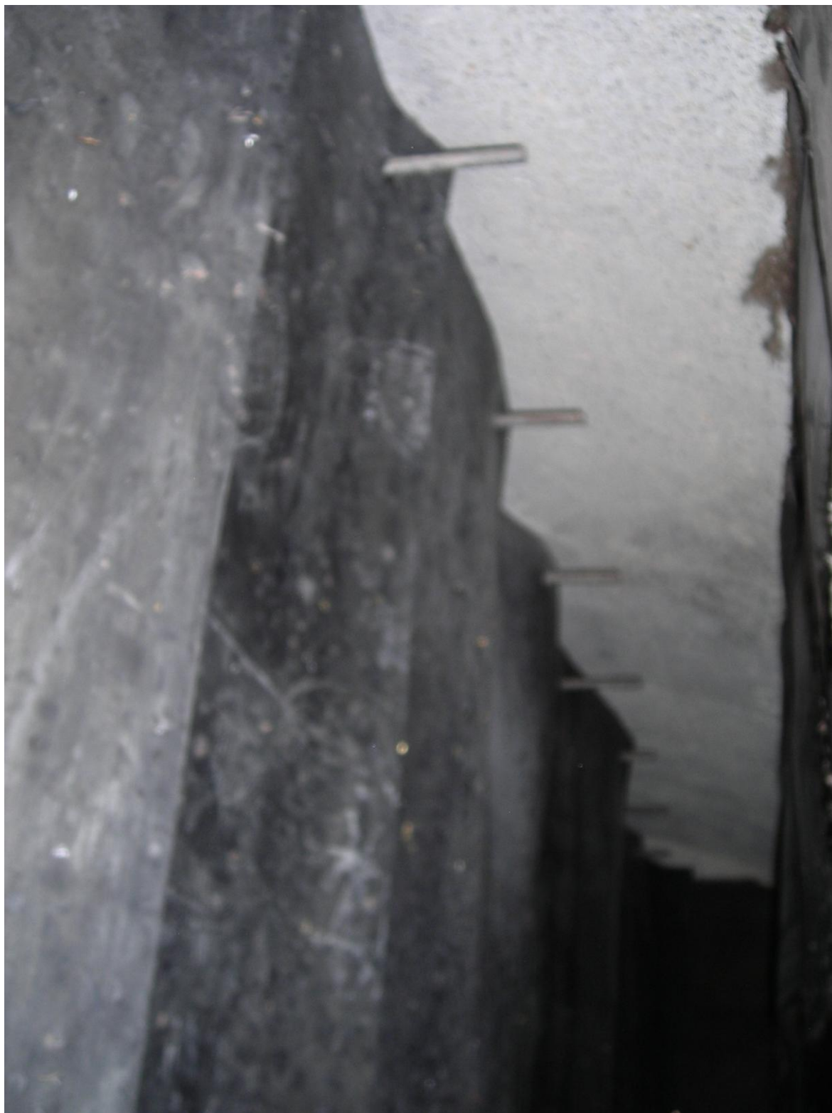
Obr. 32. Gumová clona zabraňující zpětnému odrážení střel
