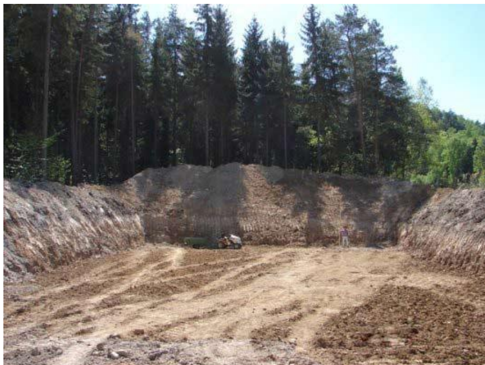
Obr. 45. Vybagrovaný hliněný val
