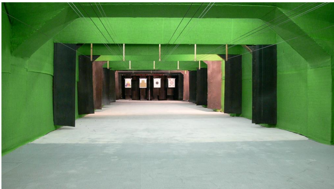
Obr. 13. Pohled na pohyblivé terče v cílovém prostoru
