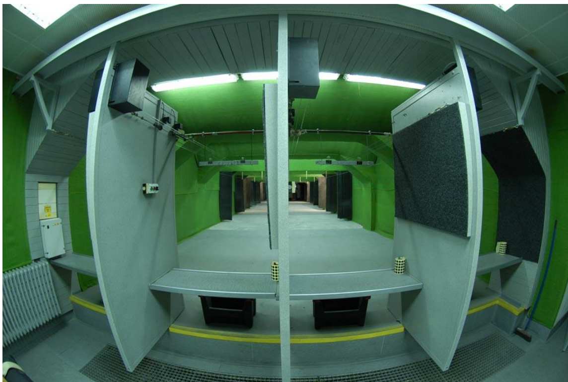
Obr. 16. Pohled na konstrukci střeleckých boxů
