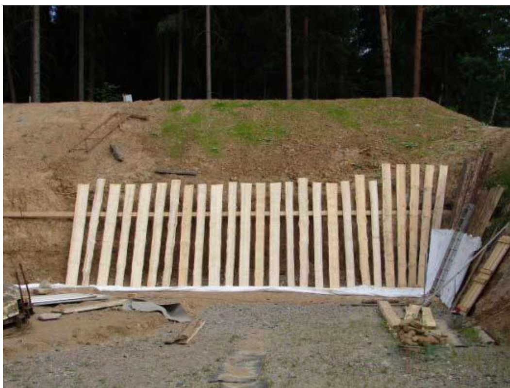
Obr. 47. Instalace oddělovací fólie
