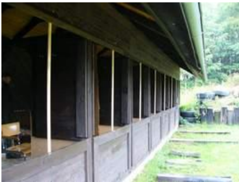
Obr. 9. Střelecké boxy polokryté střelnice
