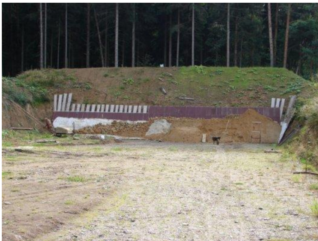
Obr. 49. Zavážení valu zeminou
