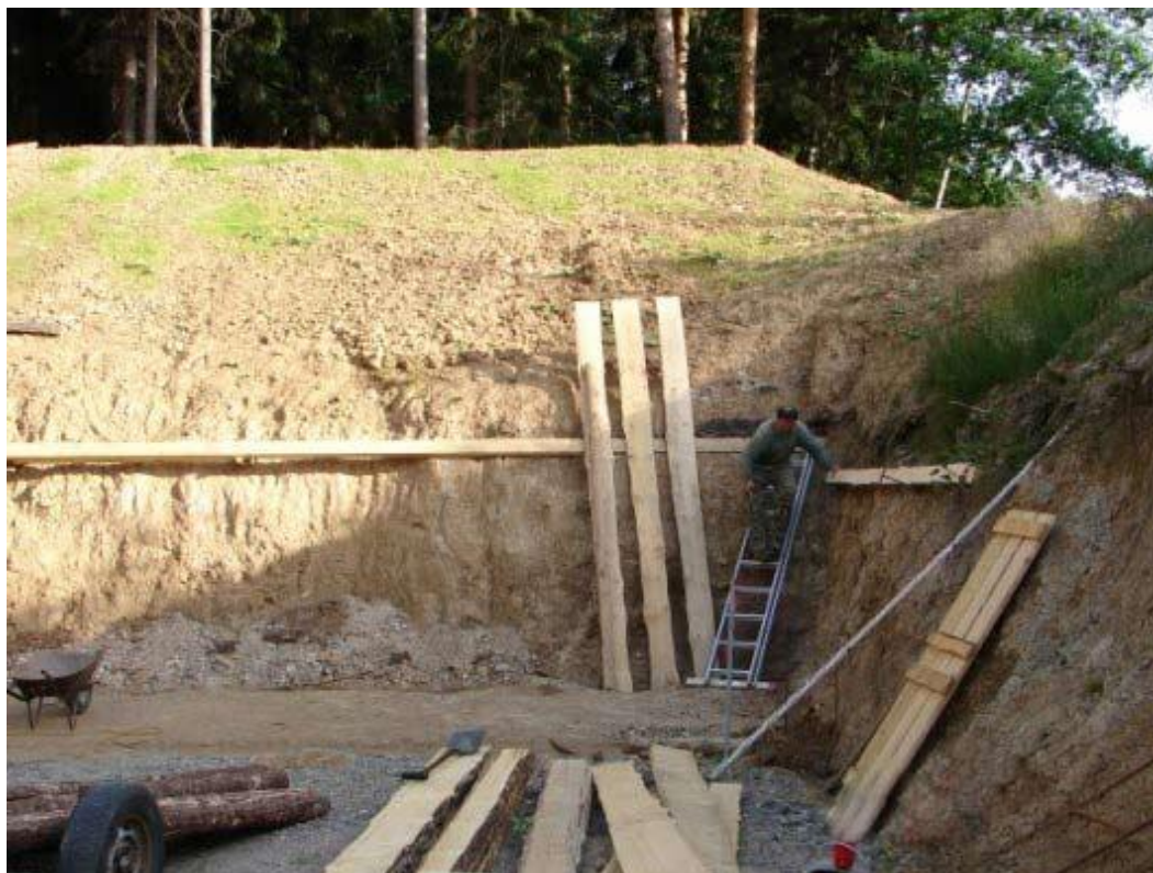
Obr. 46. Montáž dřevěné opěrné stěny
