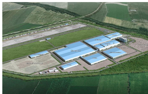
Obr. 17 Výstavba továrny automobilky Hyundai [18]
