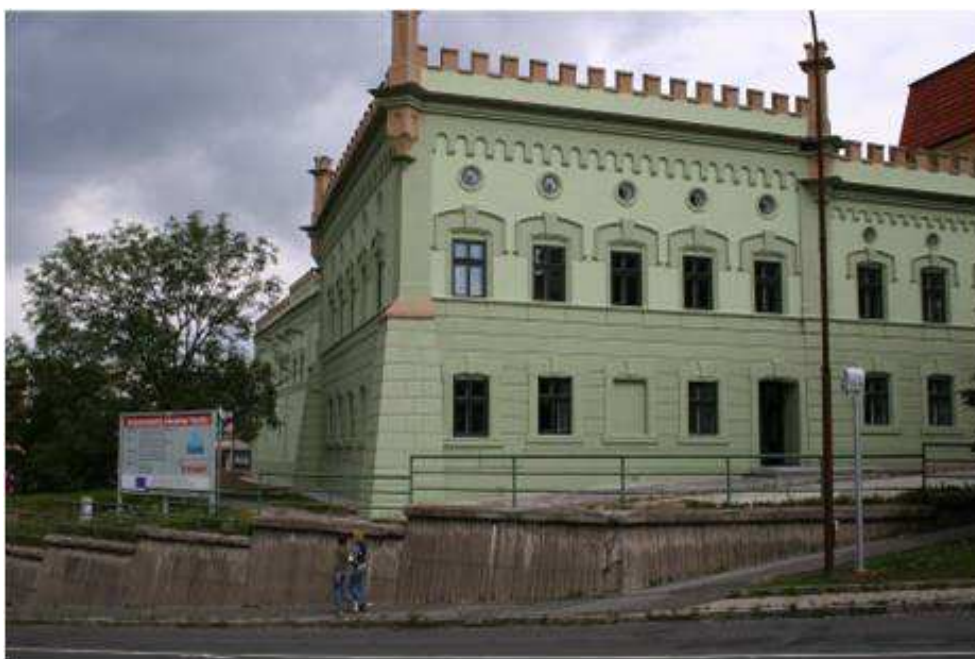
Objekt č. p. 3 na Horním náměstí zvaný „Maštaliska“ po rekonstrukci
