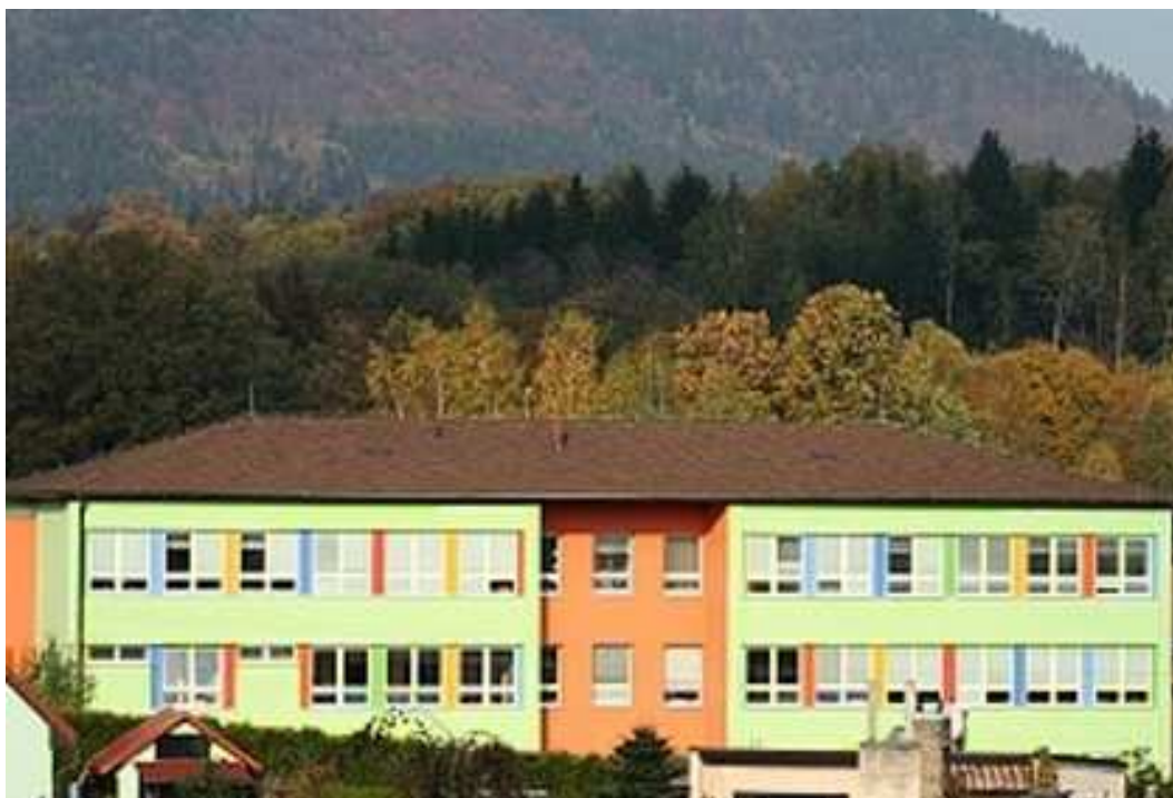
Rekonstruovaná základní škola Koryčanské Paseky
