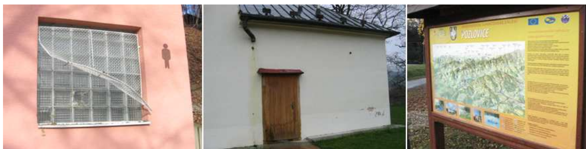
Obr. 17. Poškozená infrastruktura v městysi Pozlovice
