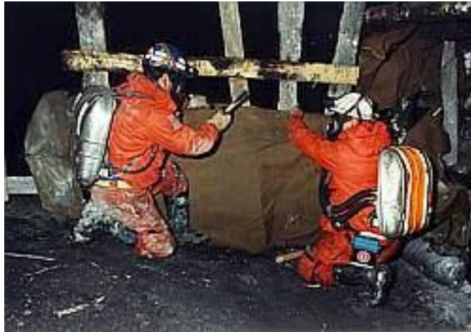
Obr. 3. Stavba uzavírací hráze ( hlavní báňská záchranná stanice Ostrava) [10]
