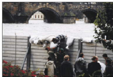
Protipovodňové bariéry Flood control barriers
