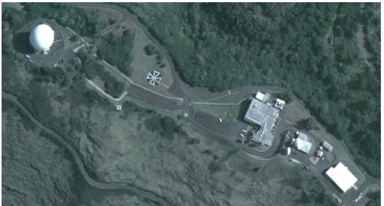
Obrázek 4 Letecký pohled na monitorovací stanici 8
