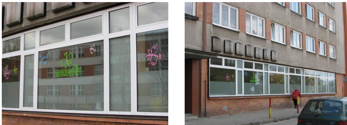
Obr. 1: Foto budovy, ve které se nachází Montessori školka (z archivu autorky)
