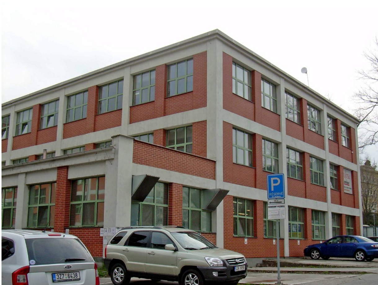
KVALITNÍ REKONSTRUKCE 41. BUDOVY fy. Impromat Computer
