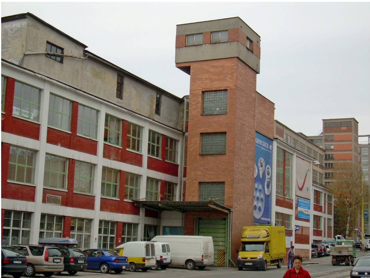
"POZORUHODNÁ" STŘEŠNÍ NÁSTAVBA při rekonstrukci měla být asanována!
