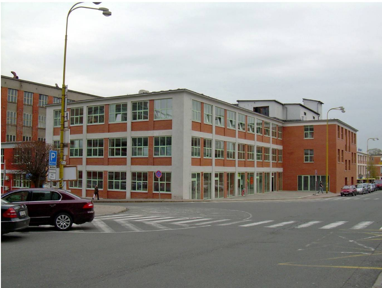
DOKONČENÁ REKONSTRUKCE 12. BUDOVY
