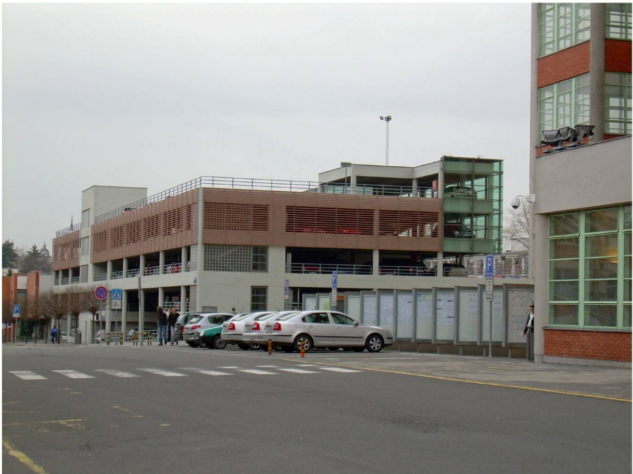
NOVOSTAVBA PARKOVACÍHO DOMU když novostavba, tak taková
