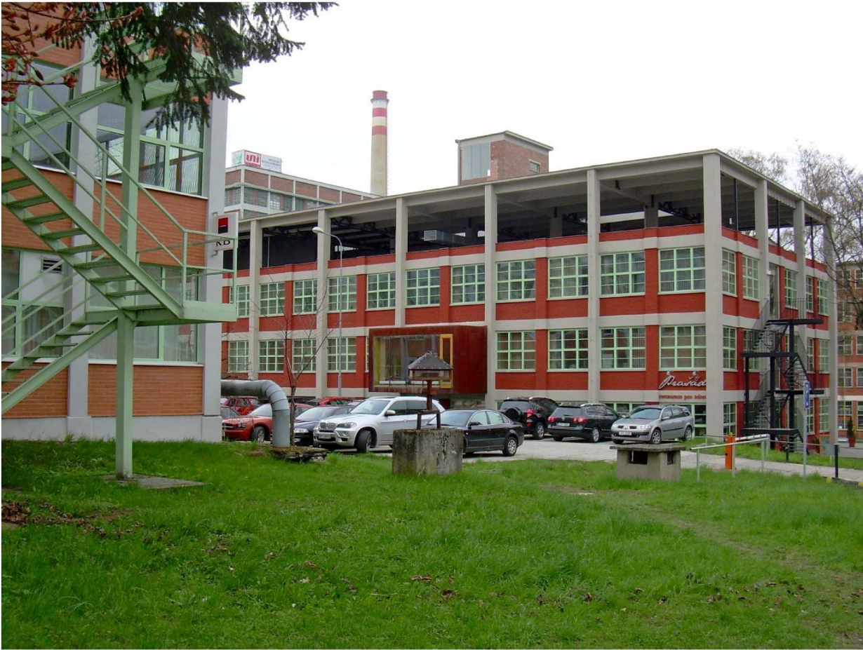
POHLED NA 23. BUDOVU OD JIHOVÝCHODU
