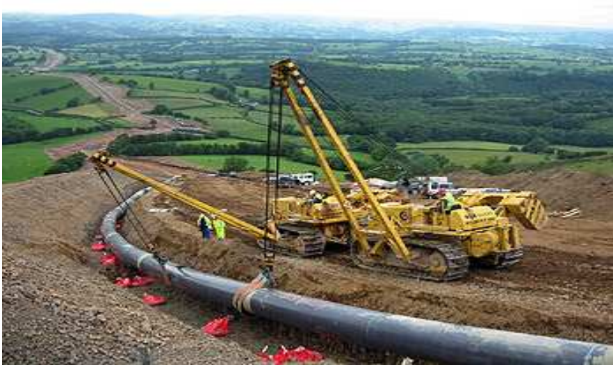
Obr. 12. Stavba ropovodu [25]
