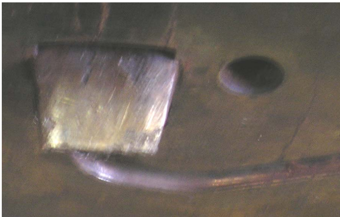
Obrázek 23 koroze části vytlačovací hlavy
