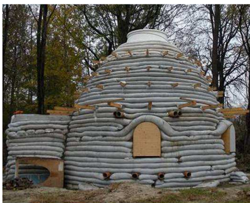
Obr. 08. Rozestavěný dům Jaroslava Duška postavený systémem SUPERADOBE v Jindřichovicích pod Smrkem (2009).
