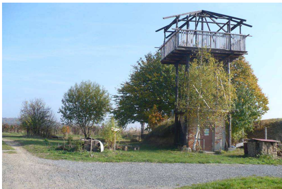
Obr. 17. Stávající stav rozhledny s vodojemem
