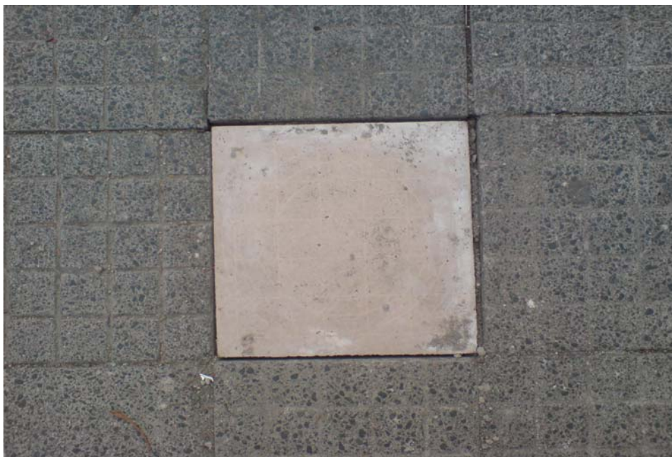
Obr. 14. Geopolymerní dlažební kostka umístěná před fakultou technologickou
