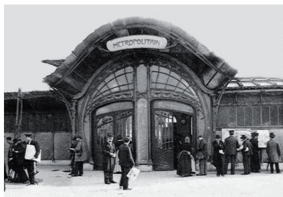
Obr. 48. Vstup stanice Bastilla, typ C, do dneška se žádný nedochoval, 1898–1904
