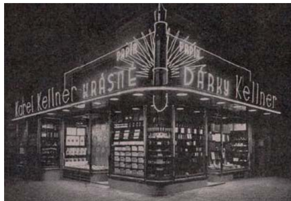
Obr. 107. Osvětlení onchodu, Praha, 1935
