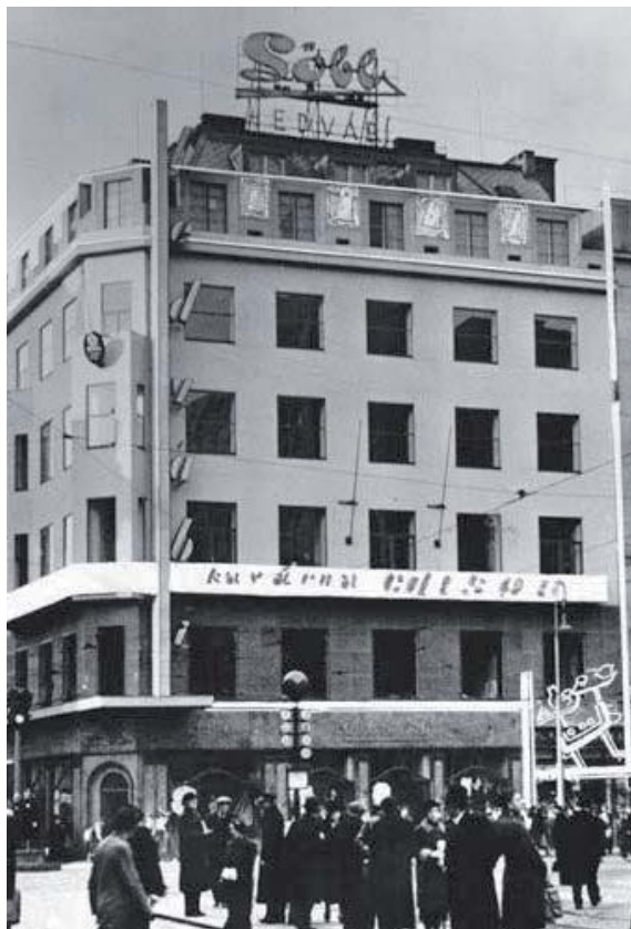
Obr. 106. Neon na domě v Praze na Můstku, 1934
