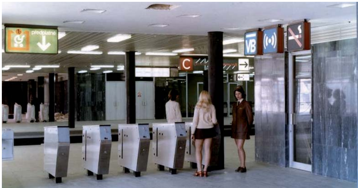
Obr. 85. Stanice metra Vyšehrad při jejím otevření v roce 1974
