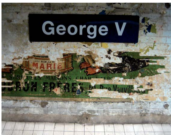
Obr. 53. Helvetica s odkrytou starou reklamou při rekonstrukci stanice
