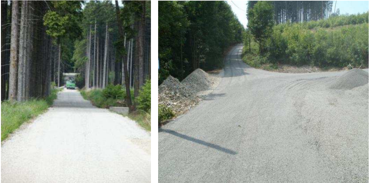
Obr. 13. Nově opravená lesní cesta v lokalitě Kolelač – Vasilsko [Zdroj: Městský úřad Slavičín]
