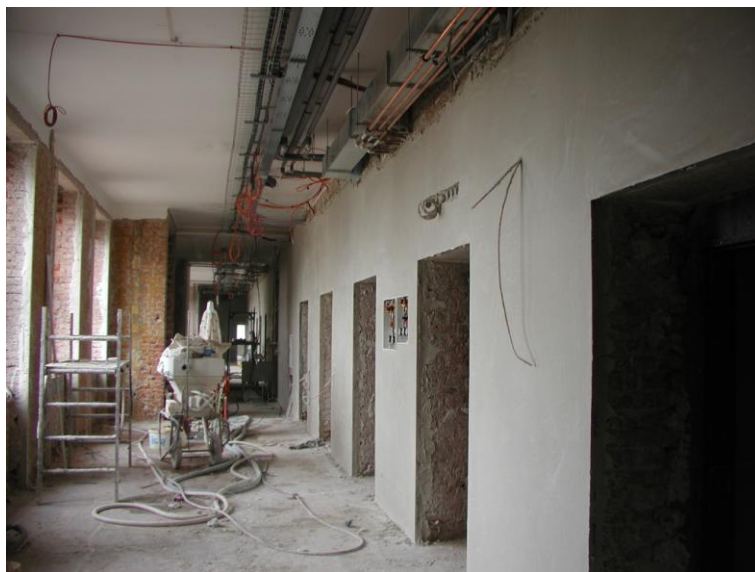
Obr. 7 Dokončovací práce vnitřních omítek [26]
