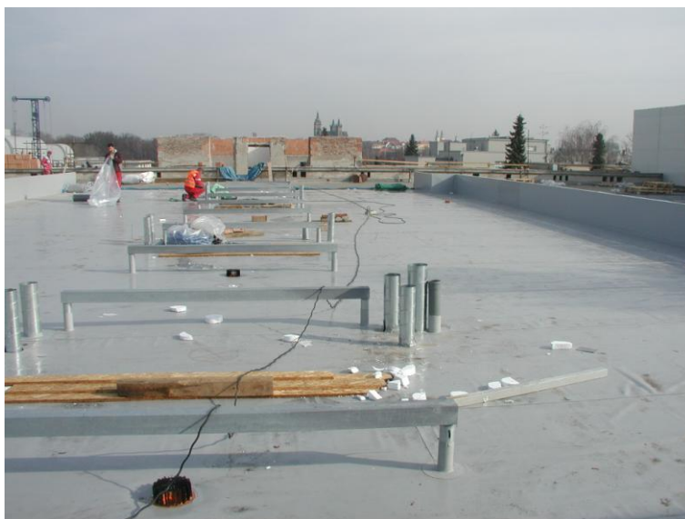
Obr. 6 Dokončovací práce na střešní konstrukci [26]
