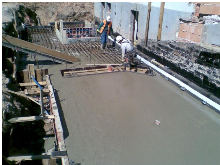
Obr. 3 Provádění spodní stavby [26]
