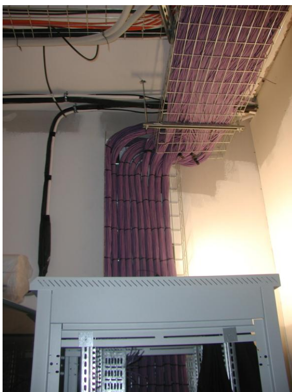
Obr. 13 Instalace vedení na kabelovém roštu [26]
