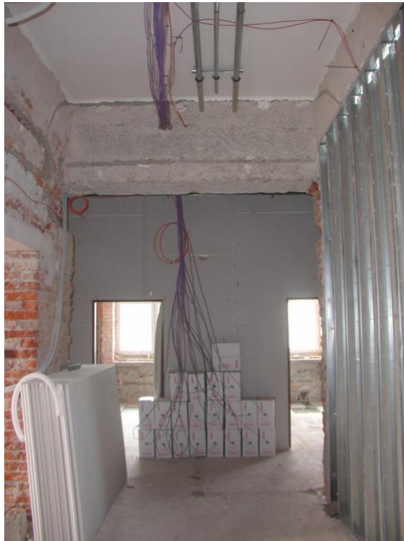
Obr. 14 Uložení kabelů nad podhledem [26]
