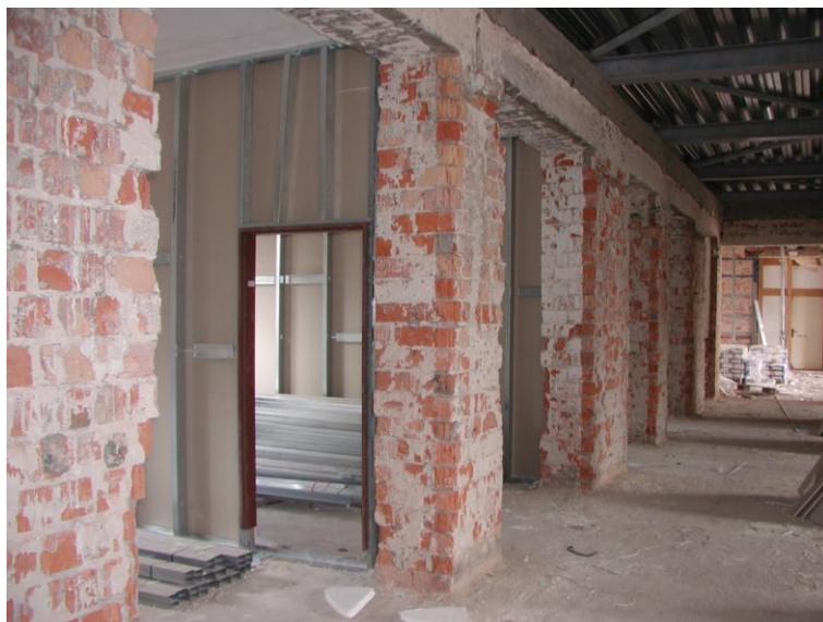
Obr. 5 Dokončené svislé nenosné konstrukce [26]
