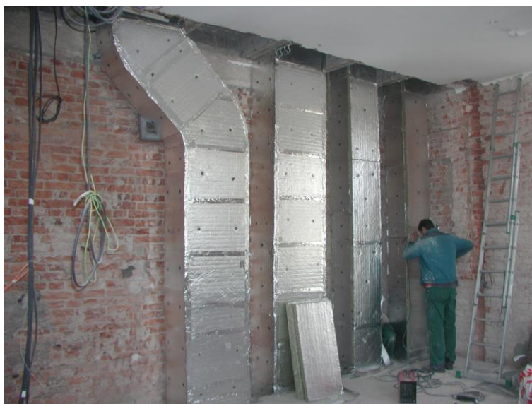
Obr. 8 Montáž vzduchotechniky a klimatizace [26]
