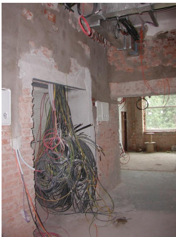
Obr. 12 Svazek kabelů před osazením rozvaděče nízkého napětí [26]
