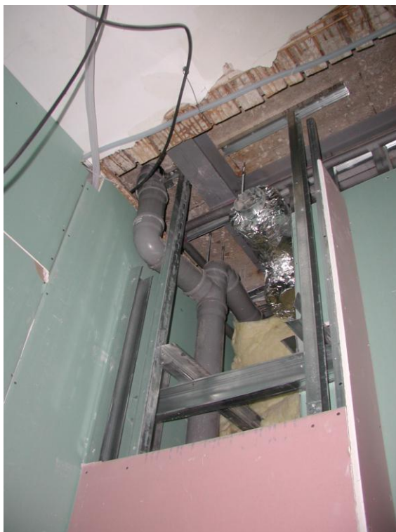
Obr. 9 Rozvody vnitřní kanalizace [26]
