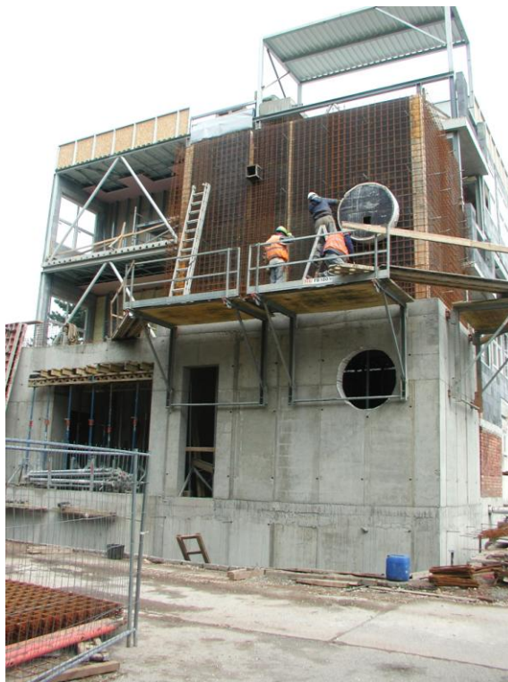
Obr. 4 Výstavba svislých nosných konstrukcí [26]
