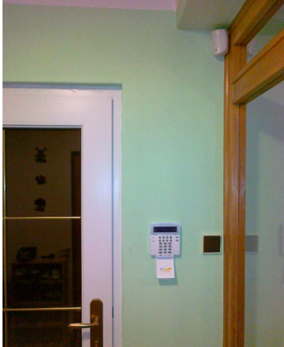
Obr. 19 Instalovaná ovládací klávesnice [28]
