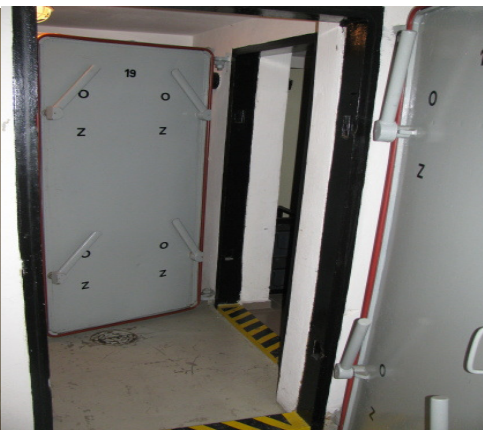
Obrázek č.7: Vstup do hlavních prostor
