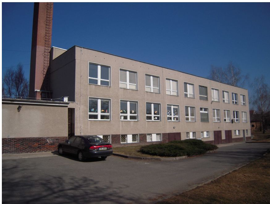
Obr. 13. Pohled na zdravotní středisko ze zadní části budovy (zdroj: vlastní)
