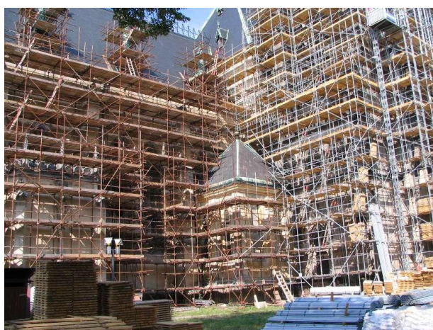
Obrázek 9 Oprava jižní zdi
