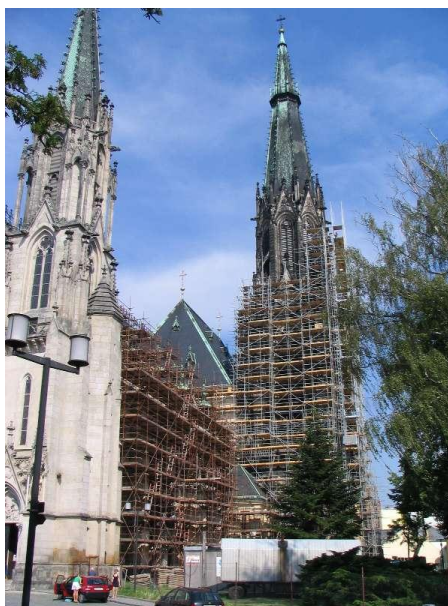
Obrázek 10 Oprava hlavní věže
