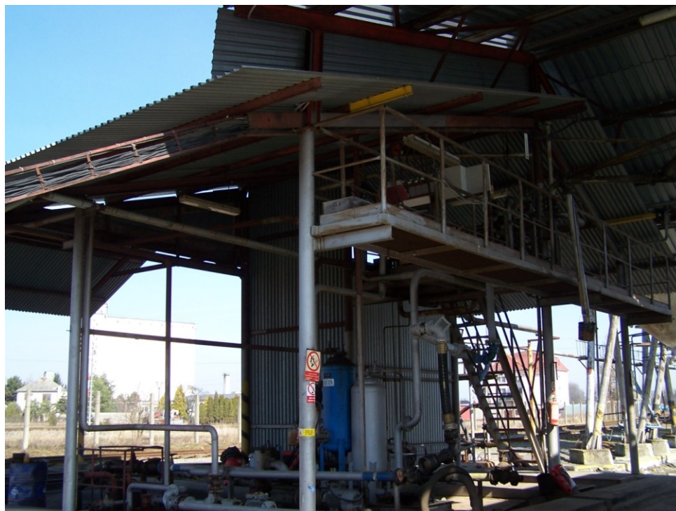
Obr. 10. Stáčiště nafty, kapalných hnojiv a mletého vápence
