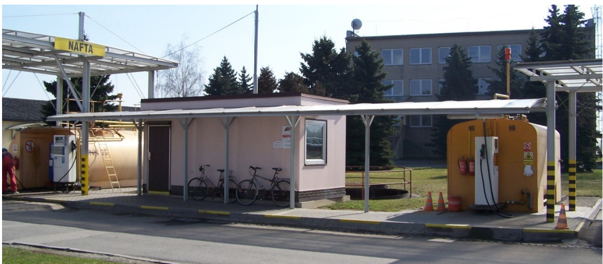
Obr. 7. Čerpací stanice pohonných hmot
