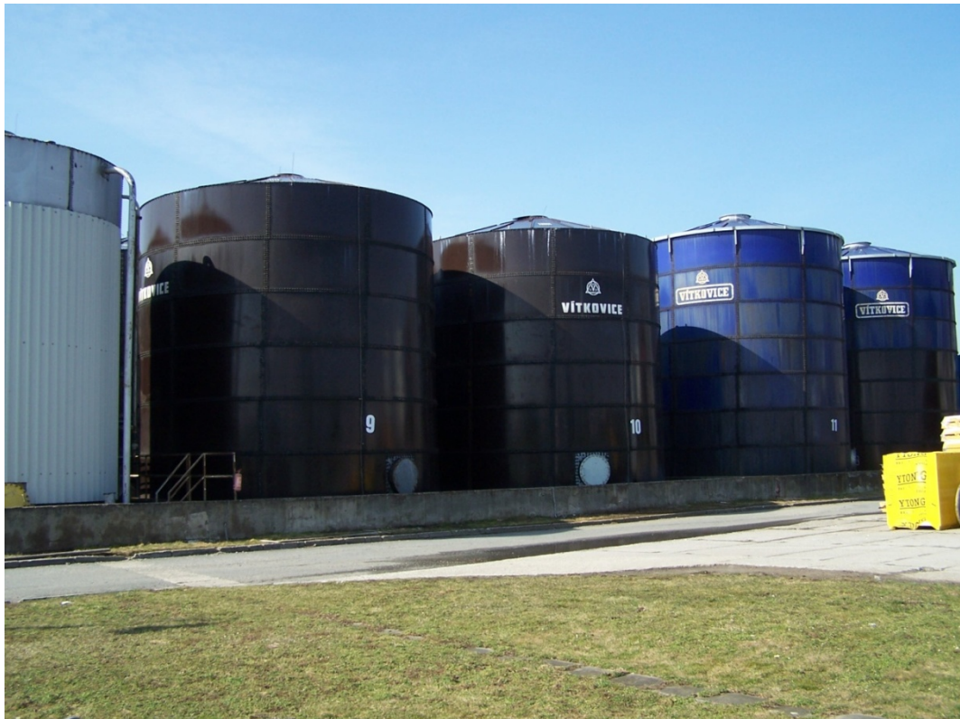
Obr. 12. Boční pohled – velkokapacitní zásobníky na kapalná hnojiva
