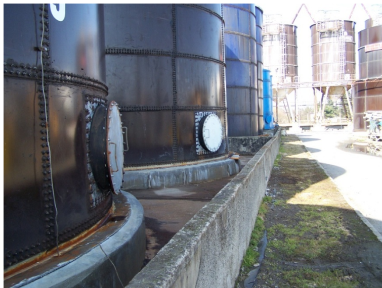
Obr. 13. Detail zachytných jímek na kapalná hnojiva
