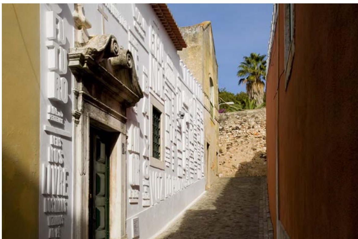
Obr. 35 – Ukázka typografické instalace kaple Ermida Nossa Senhora da Conceição, 2009
