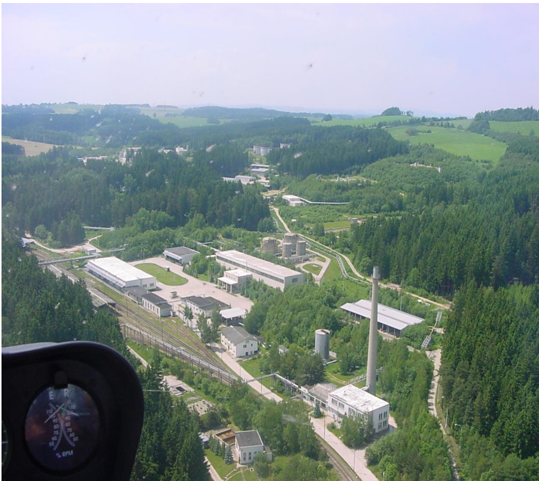
Obrázek č. 2: Letecký pohled na středisko Čepro a.s. Šlapanov[32].
