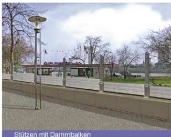
Obr. č. 16 – Ukázka hliníkových hradidel
