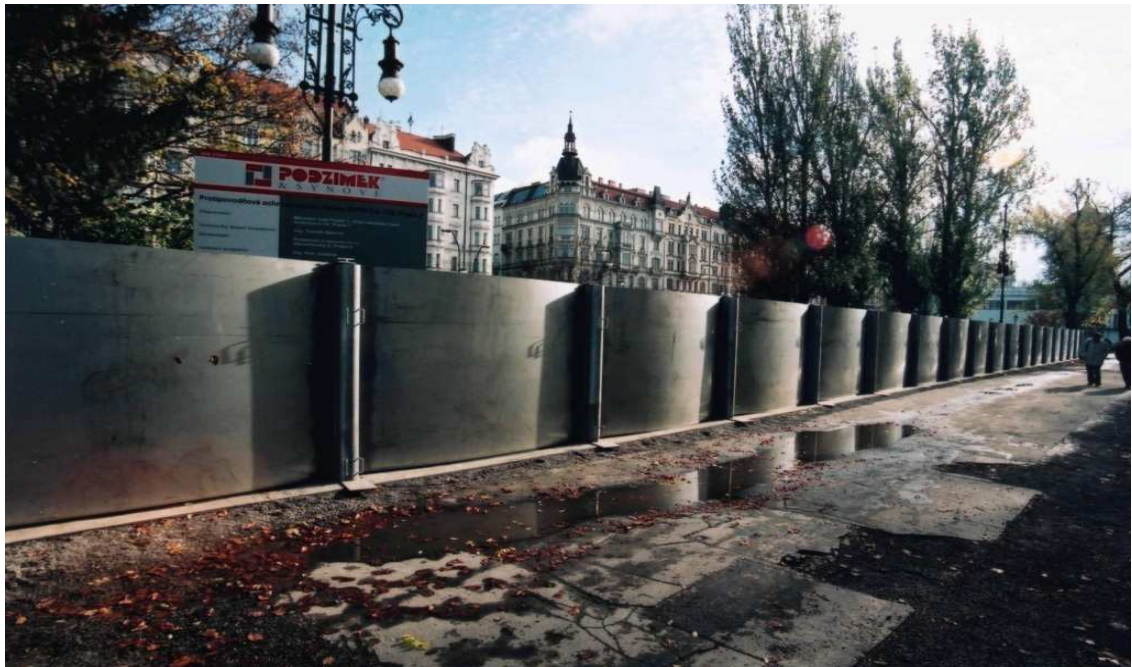
Obr. č. 17 – Membránové protipovodňové hrazení
