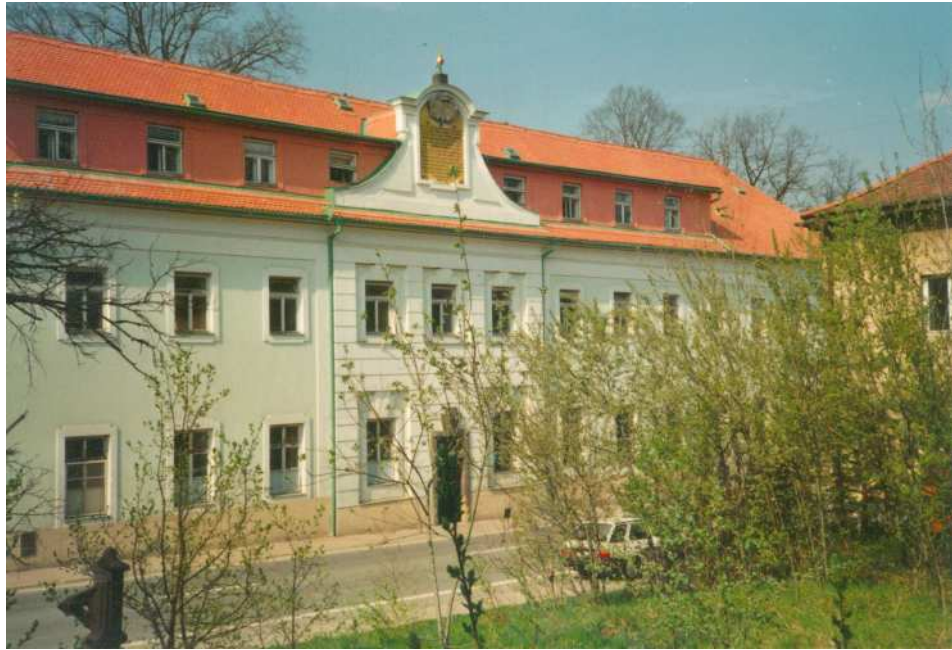
Obr. 1 Čelní pohled na budovu NMB Vizovice
