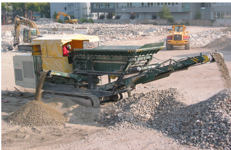
Obr. 4. Recyklace stavebních odpadů [24]
