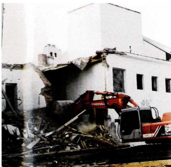
Obr. 3. Demolice bývalé charity
