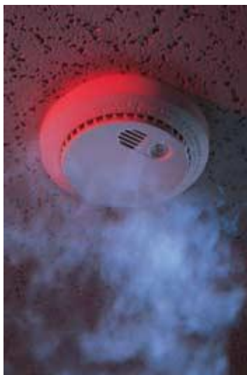
Obrázek 6: Ukázka kouřového detektoru; zdroj [16]
