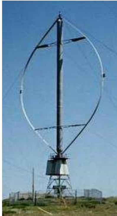
Obr. 7. Příklad odporové elektrárny typu Darrieus. [7]
