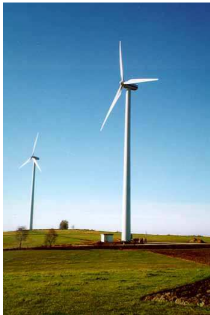
Obr. 6. Příklad klasické elektrárny s vodorovnou osou otáčení [7]
