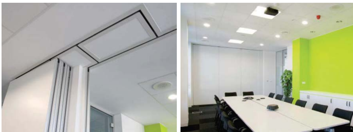
Obr. 3 (vlevo): Detail kolejnice kotvené do podhledu
