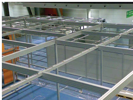
Obr. 13 (vlevo): Ukázka hliníkových profilů systému Octanorm
