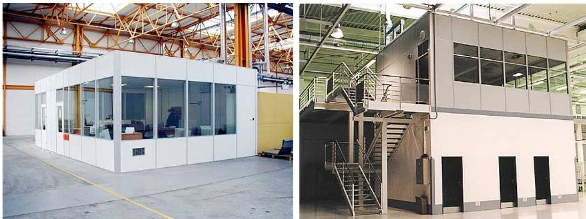
Obr. 5 (vlevo): Ukázka vestavky, ABB Brno
