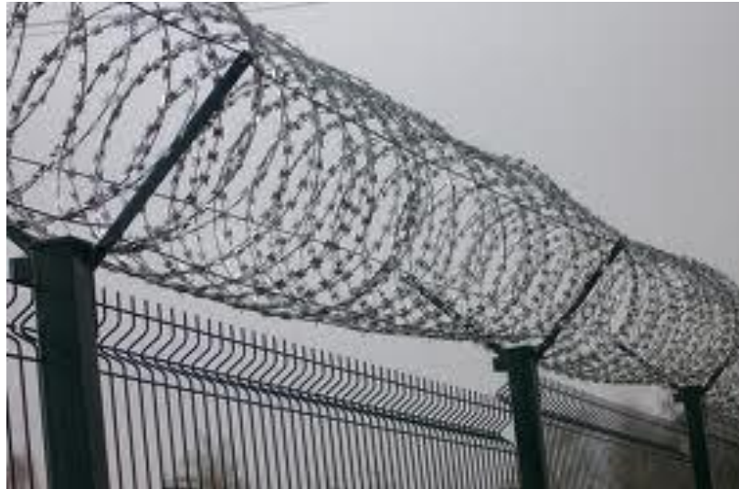
Obr. 2 Vrcholová zábrana[8]
