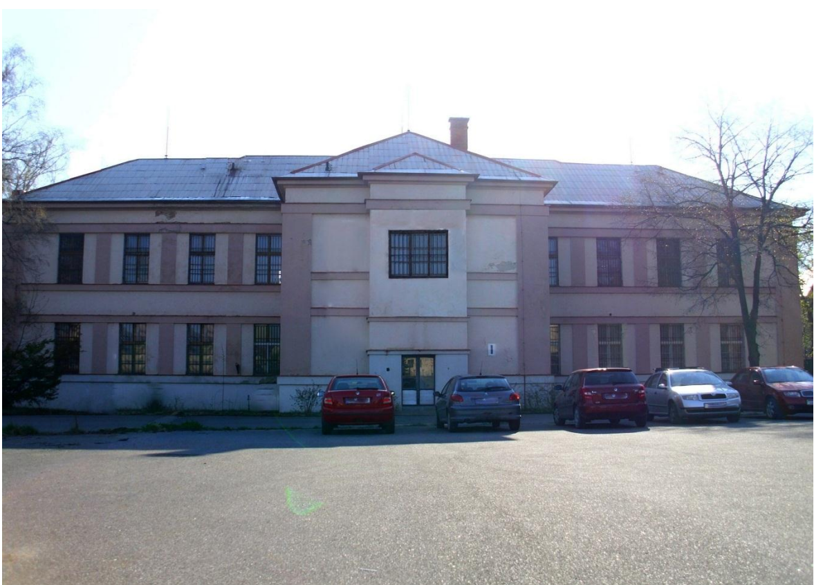
Obr. 5 Pohled na přední stranu objektu s vchodem
