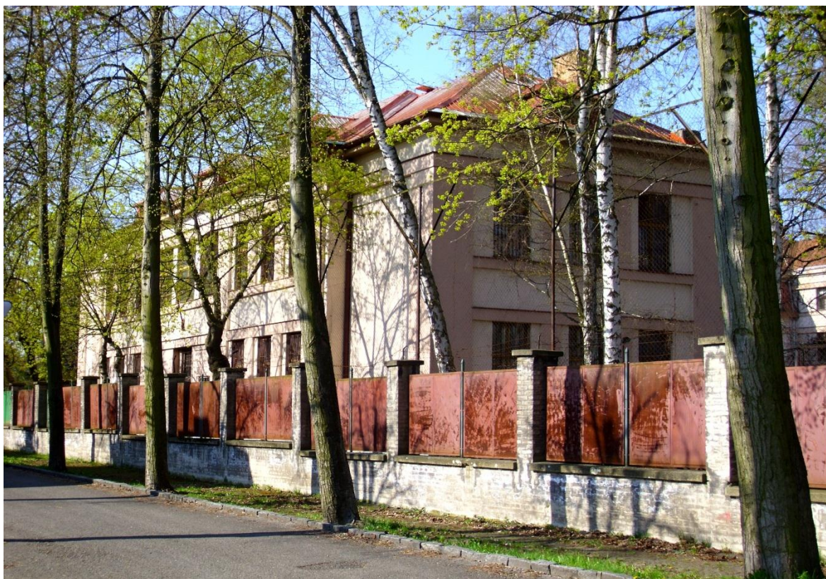
Obr. 9 Pohled z ulice na levou a zadní část objektu a oplocení
