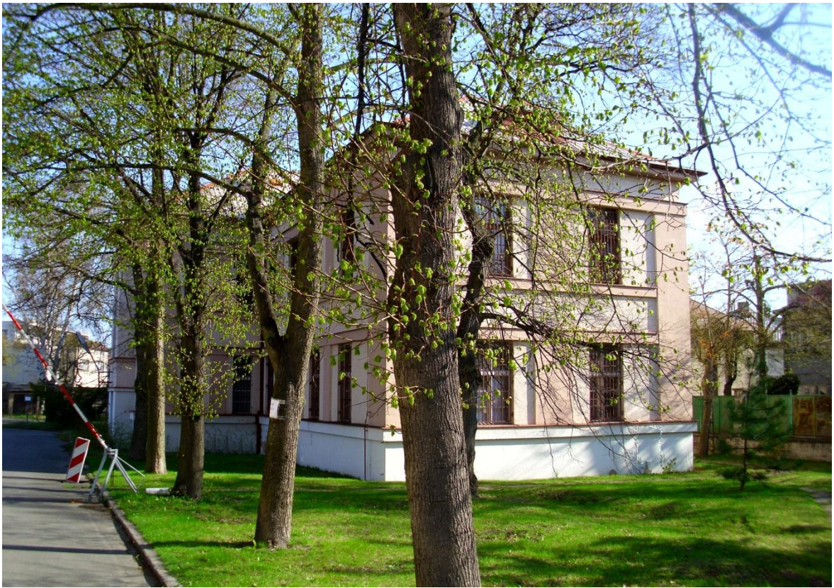
Obr. 6 Pohled na objekt z boku
