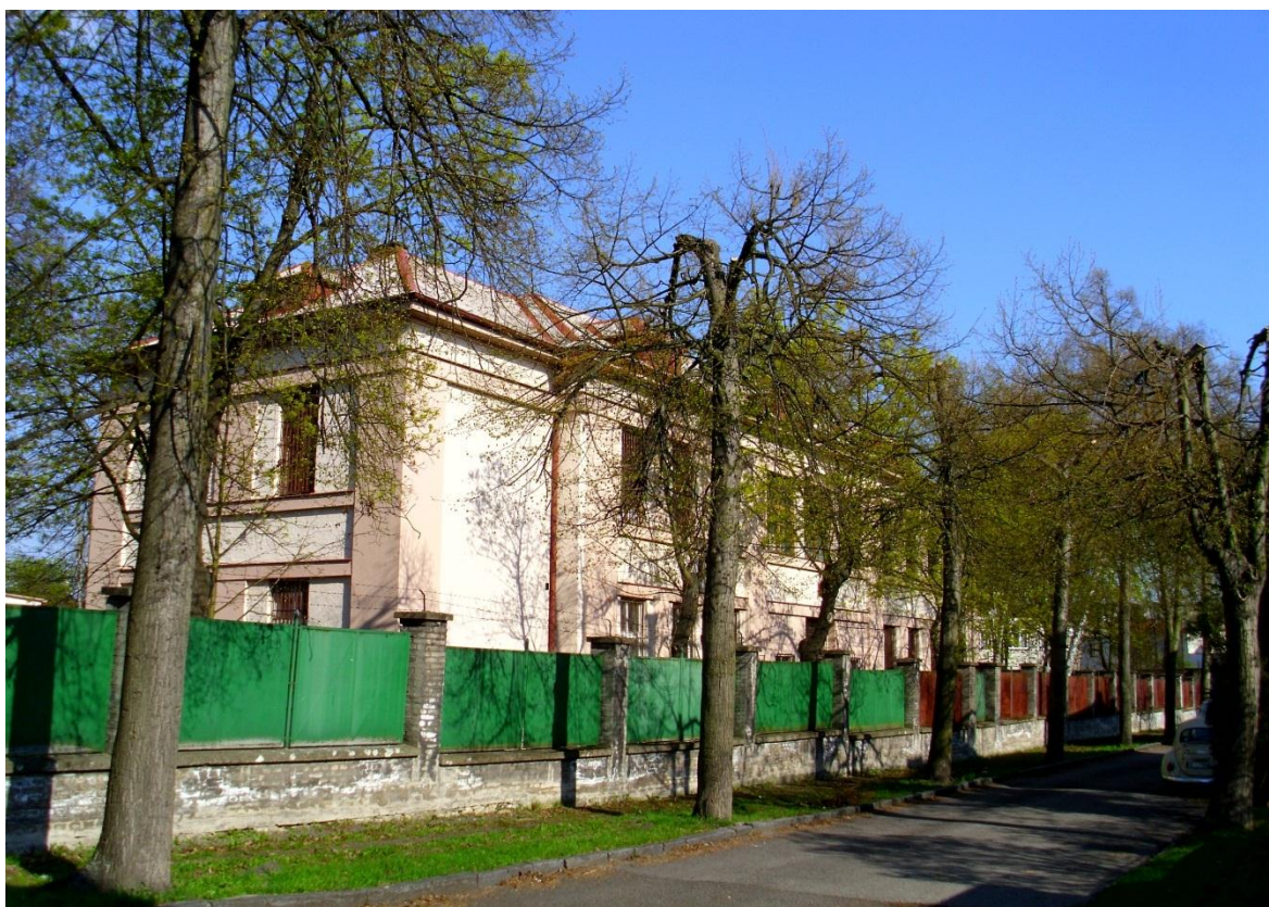
Obr. 8 Pohled z ulice na pravou a zadní část objektu a oplocení
