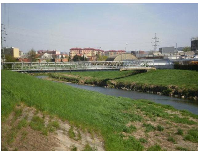
Obr. 20: Potrubní most, lávka pro pěší (D10)
