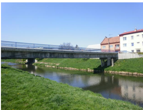
Obr. 14: Lávka na Zámostí (D4)
