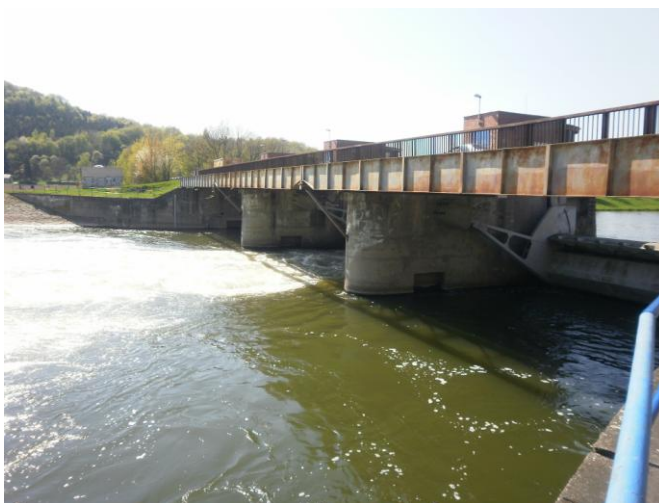
Obr. 24: Jez Bělov, včetně budované vodní elektrárny (M1)
