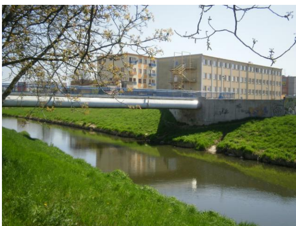
Obr. 17: Lávka u železničního mostu (D7)
