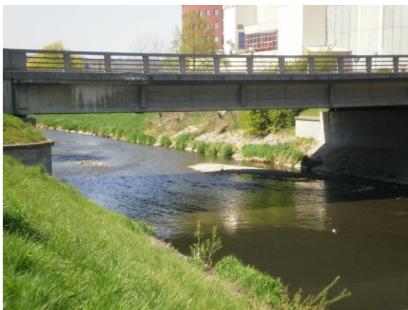
Obr. 15: Silniční most komunikace I/55 (D5)
