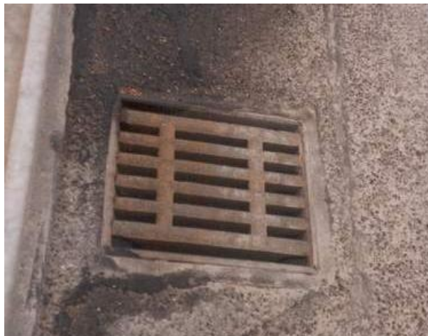
Obrázok 16: Kanalizačný otvor pre odtok povrchovej vody
