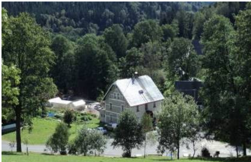
Pohled na objekt chráněného bydlení Neratov
