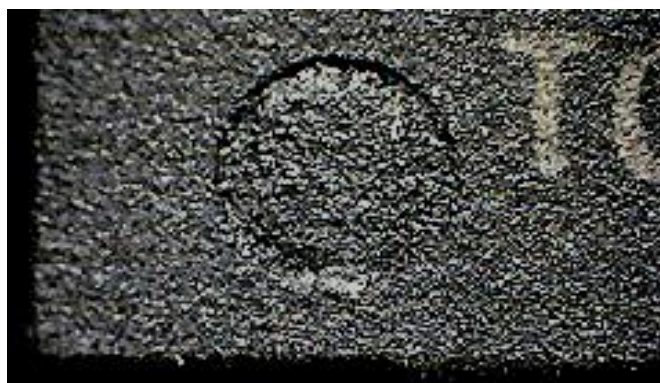
Obrázek 19: Kontrolní značka překrytá novým povrchem [13]
