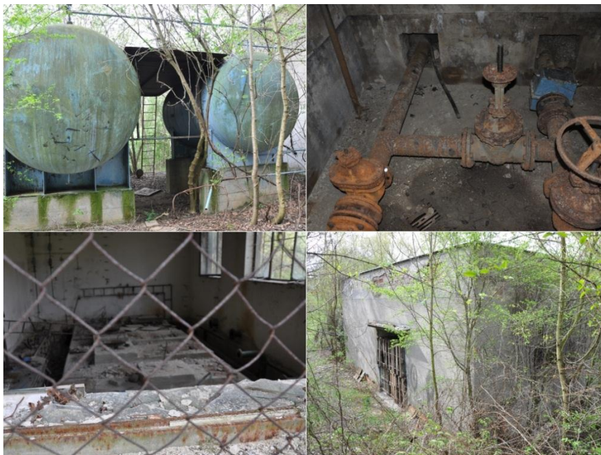
Obrázek 13: Aktuální stav čerpací stanice v podhrází.
