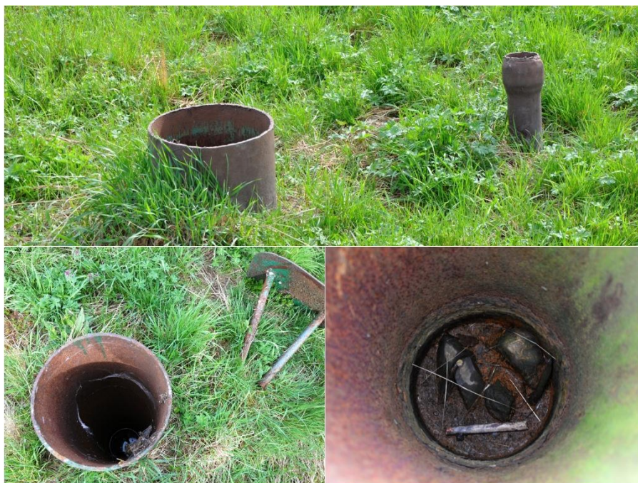
Obrázek 16: Stav některých pozorovacích a odvodňovacích vrtů.
