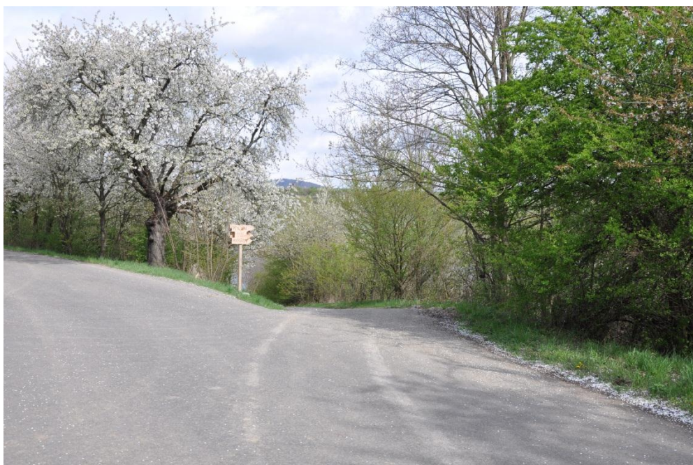
Obrázek 10: Chybějící dopravní značení na příjezdové komunikaci.
