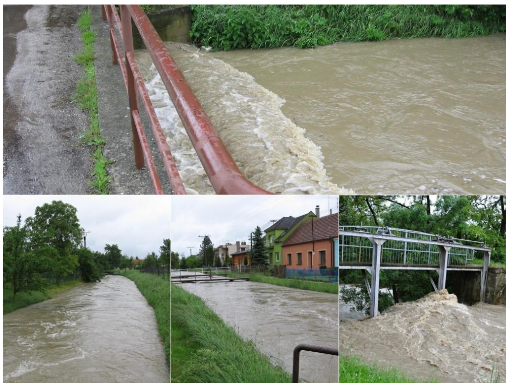
Velká voda v roce 2010 protékající obcí Boršice.
