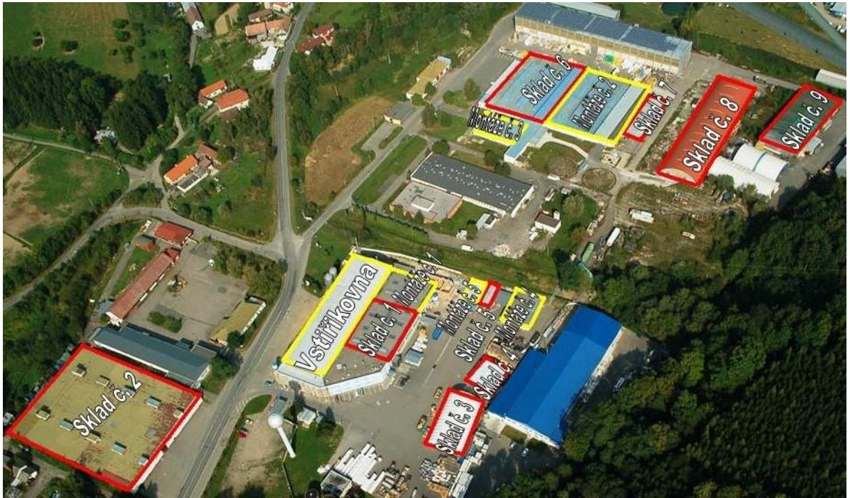
Obrázek č. 31 Stávající skladové prostory
