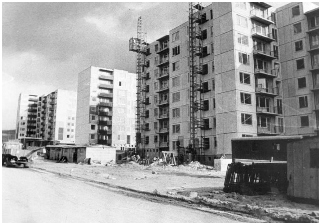
Obr. 14 Výstavba panelového sídliště v Brně-Líšní, konstrukční typ B 70
