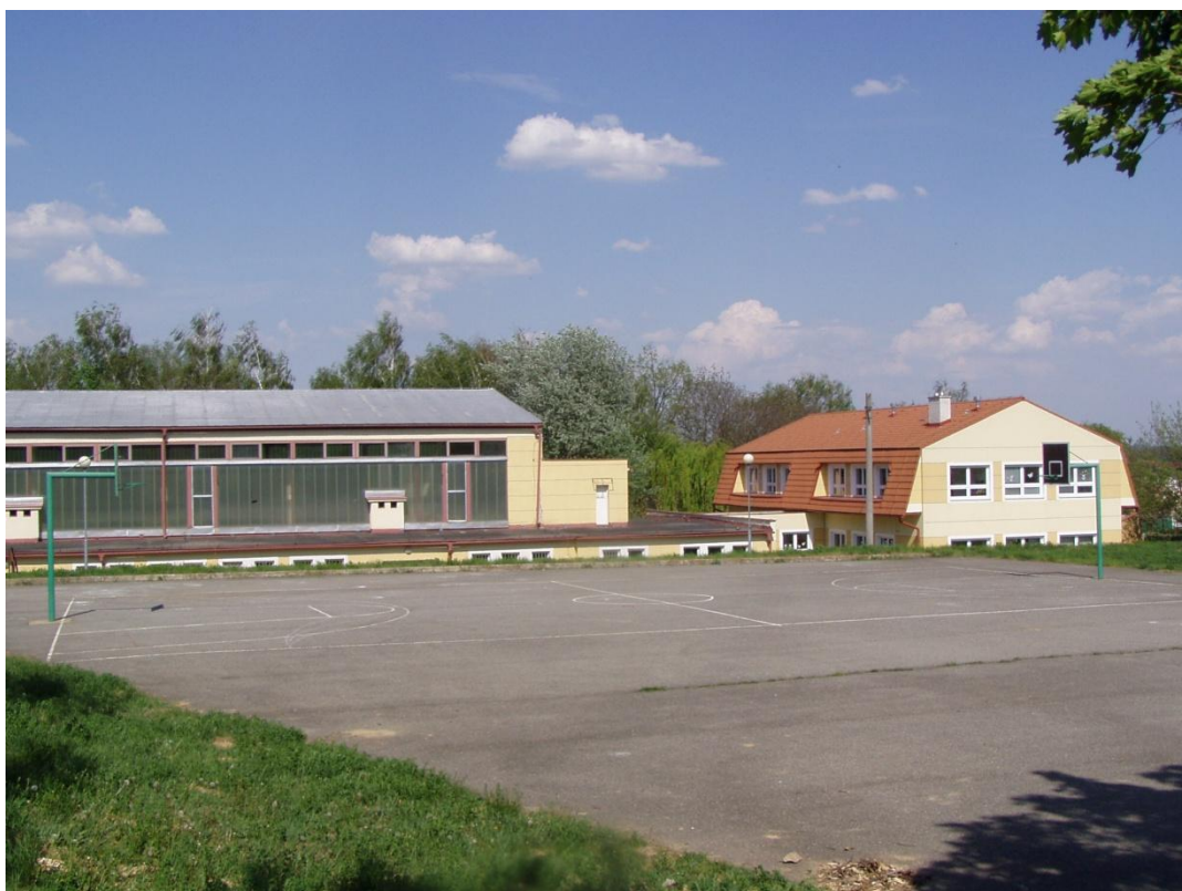
5) Tělocvična ZŠ ze strany basketbalového hřiště
