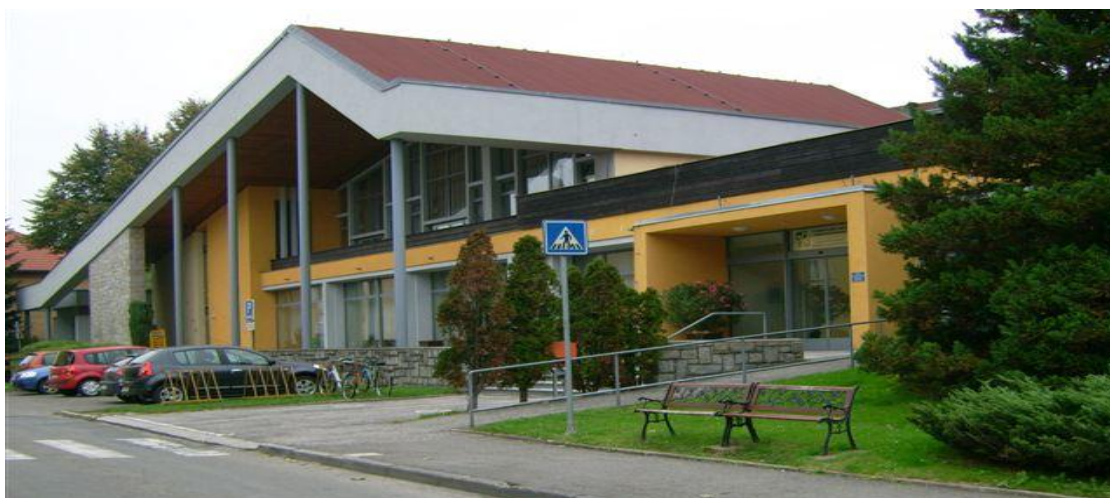
Obr. 3. Budova Domova pro seniory Rožnov pod Radhoštěm
