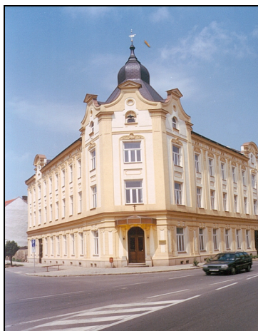
Obr. 1. Budova OSSZ Kroměříž
