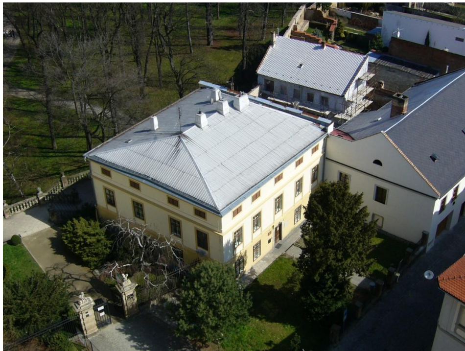
Obr. 3 Budova OCH KM – kancelář CHPS
