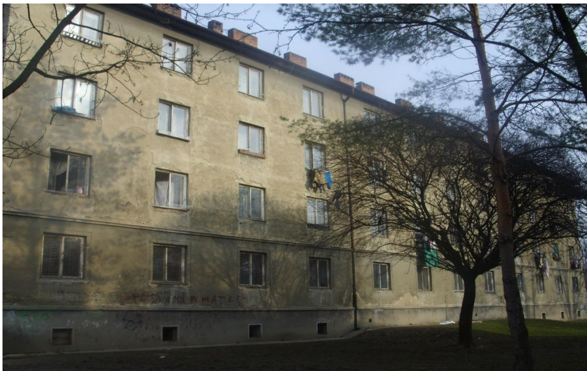
Obr. č. 3 - Ubytovna na ulici Markéty Kuncové 2 v Brně – pohled na stranu ubytovny, která je směrem k bývalému areálu Zbrojovky Brno.
