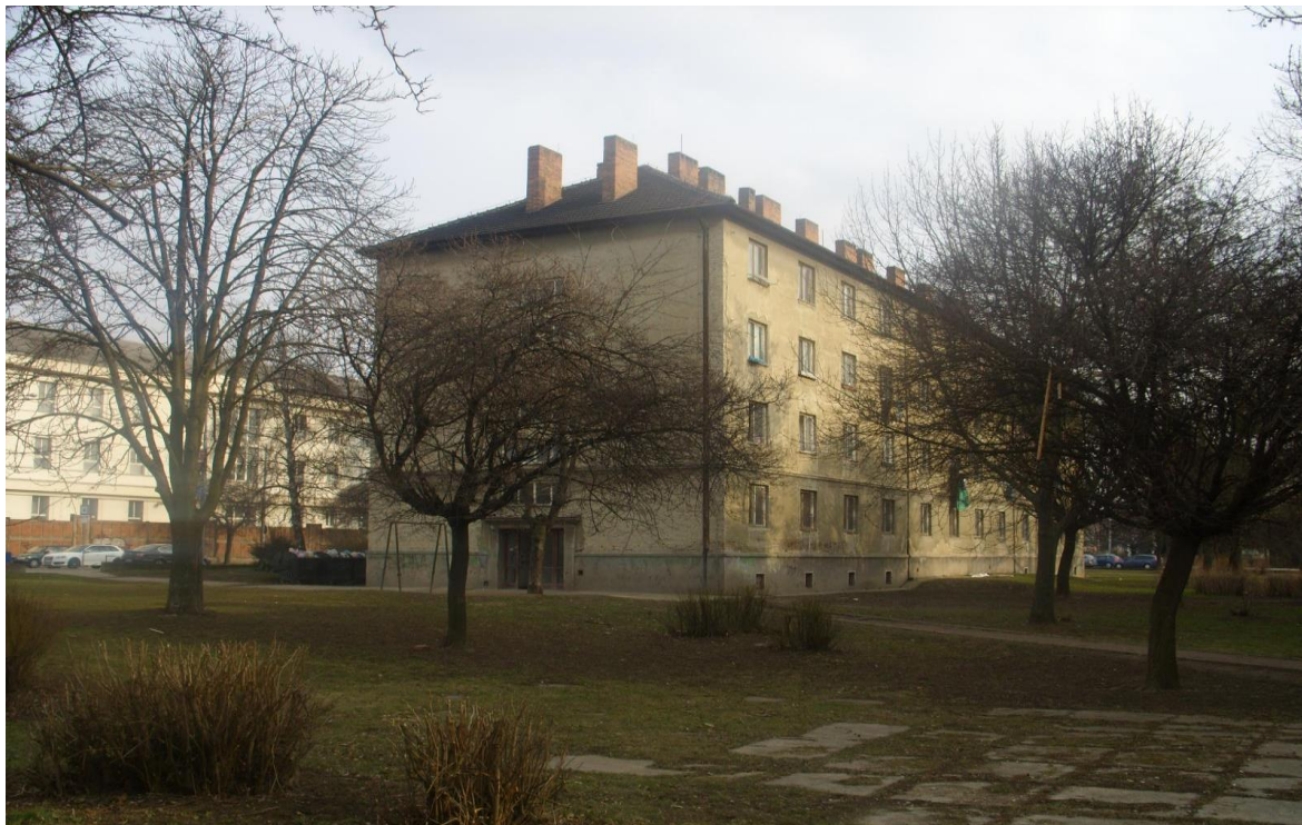
Obr. č. 1 – Ubytovna na ulici Markéty Kuncové 2 v Brně – pohled na vstup do objektu
