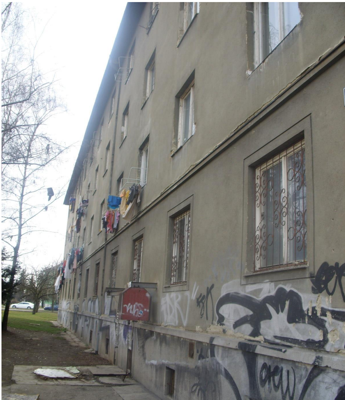
Obr. č. 5 - Ubytovna na ulici Markéty Kuncové 2 v Brně – pohled na stranu ubytovny, která je směrem na ulici Svatoplukova.
