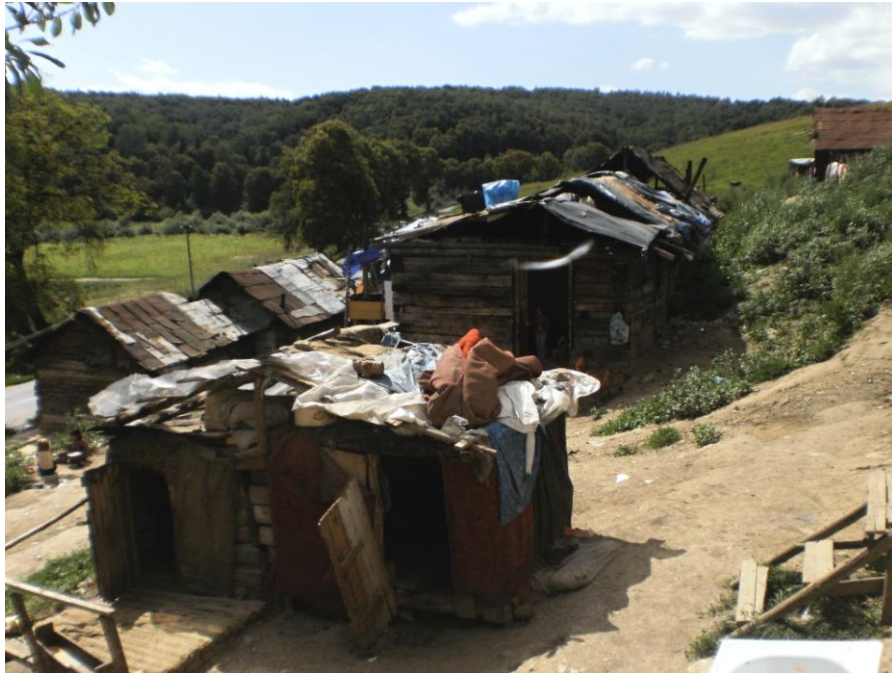
Obr. 3 – Střechy domů ze staré zástavby. V popředí bouda pro psy.
