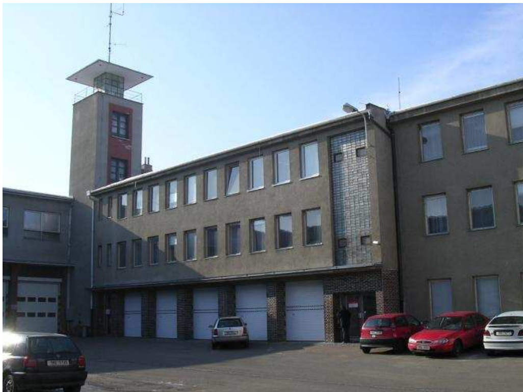
Obrázek č. 1 – Požární stanice Prostějov
