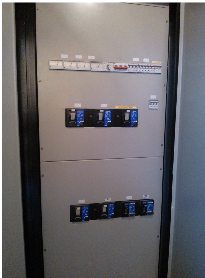
Obrázek 17: Hlavní jističe
