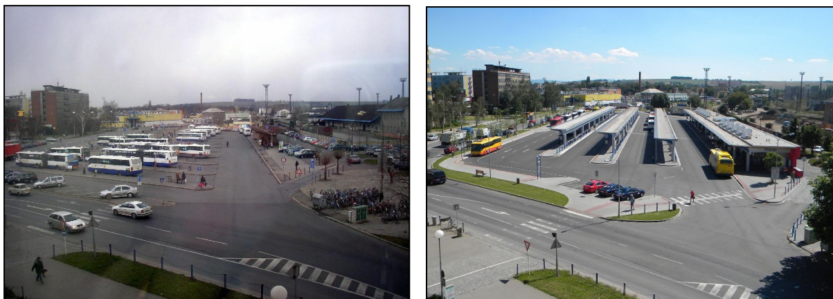
Obr. 7 Pohled na autobusové nádraží před a po rekonstrukci zdroj: Statutární město Pířerov (MMPř, 2010)
